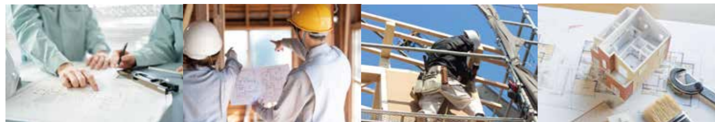
● 施工管理:現場打ち合わせ
